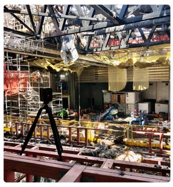
Innovative Intelligence 利用 Focus<sup>M</sup> 70 激光扫描仪准确捕捉到火灾给新西兰奥克兰市 SkyCity 会议中心顶层造成的损失的三维细节。
