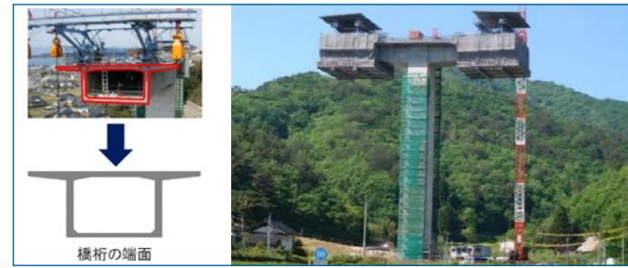
(왼쪽) 측정 대상이 되는 다리 거더 단면의 형상 (오른쪽) 캔틸레버 공법에 의한 콘크리트교의 건설 현장.
