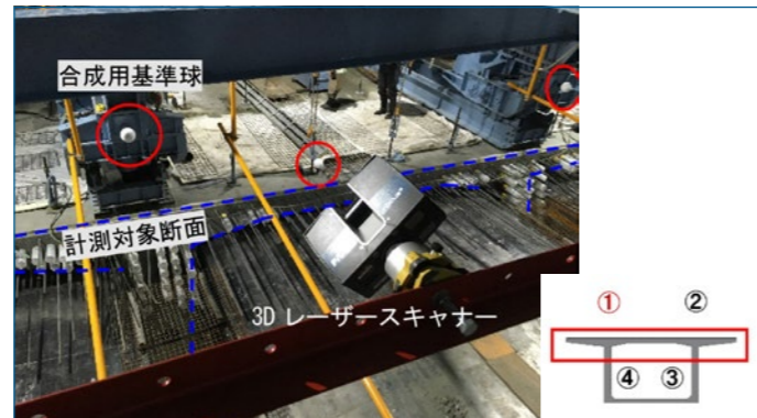
다리 거더 상부로부터의 포인트 클라우드 측정 Focus s 350을 옆쪽으로 달아 포인트 클라우드를 합성하는 기준구를 설치.
