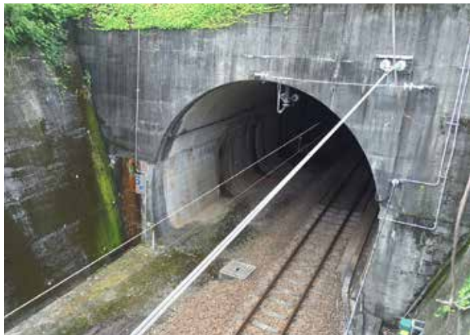
측량 중인 터널 원천.
