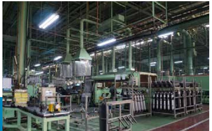
배기시스템을 생산하는 칼소닉칸세이코리아의 생산현장.
