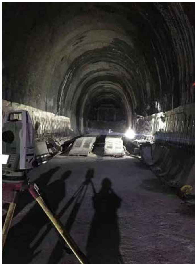
隧道施工现场情况。
