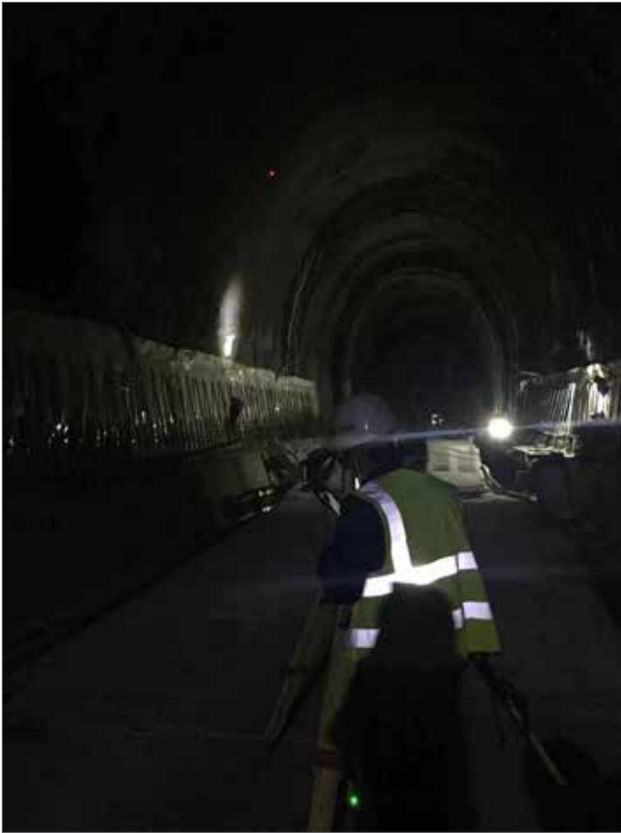
工作人员正在人工采集隧道断面。
