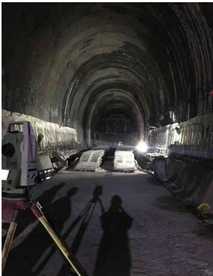
トンネル建設現場の状況。
