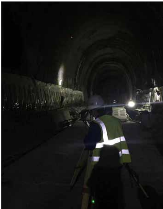
作業員がトンネルの断面データを収集している。
