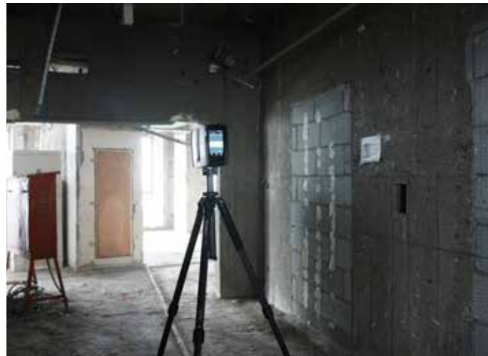
軽量のFARO 3Dレーザースキャナーを現場検査で使用。
