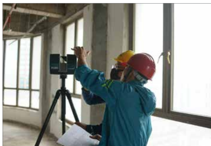
FARO 3Dレーザースキャナーで室内空間をスキャンしているところ。
