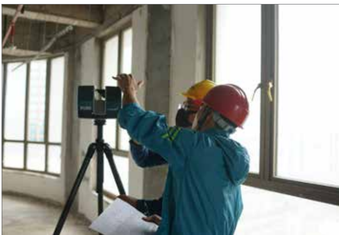
舜元团队使用 FARO 三维激光扫描仪进行扫描。
