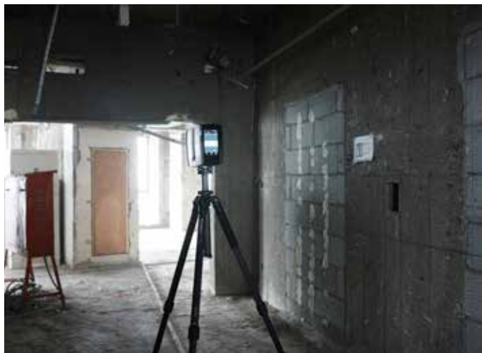
FARO 三维激光扫描仪在扫描现场场景。
