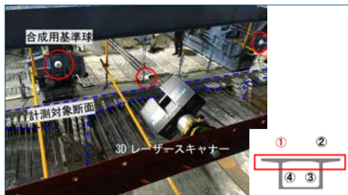
橋桁上部からの点群計測。Focus s 350を横向きに取り付け、点群を合成する基準球を設置
