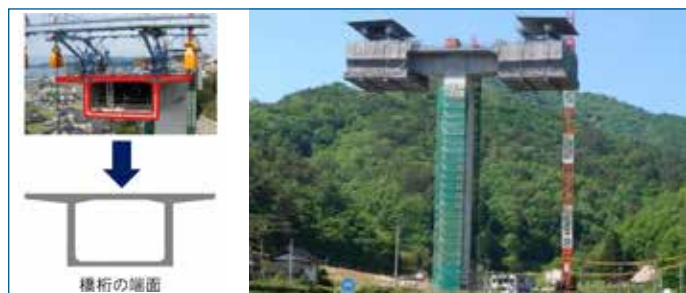
(左) 計測対象となる橋桁断面の形状 (右) 張出し架設によるコンクリート橋の建設現場
