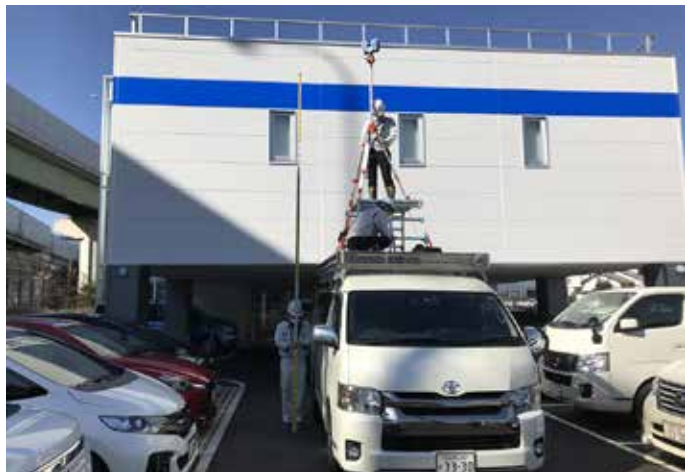
社有車にキャリアを搭載しその上に足場を組んで、6mの高さにスキャナーを設置。高いところへ上げることで、橋梁などの大型構造物も少ない回数でスキャン可能。随所に工夫を凝らして、作業効率を向上。
