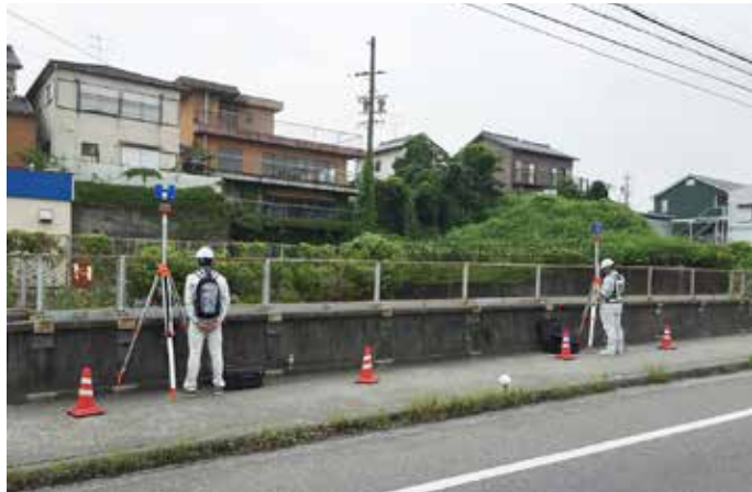
トンネル坑口の写真(上)とFocus 3D X 330を使った点群計測作業(下)
