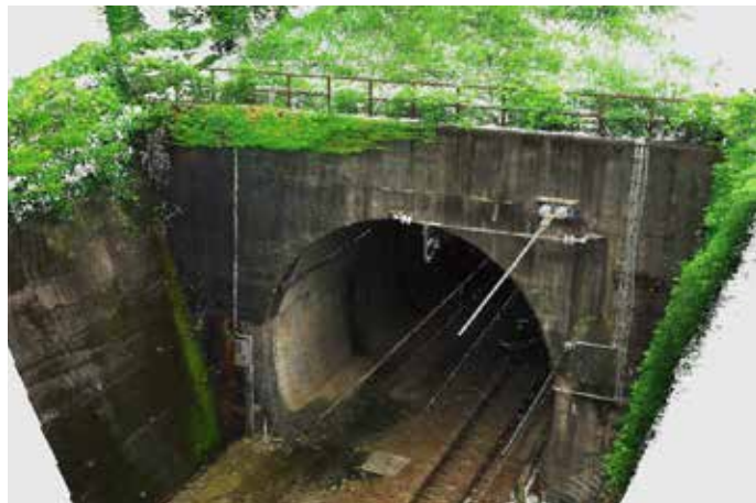
計測された坑口の精密な点群データ。トンネル構造物本体のほか、周囲の手すりや電線なども忠実に記録
