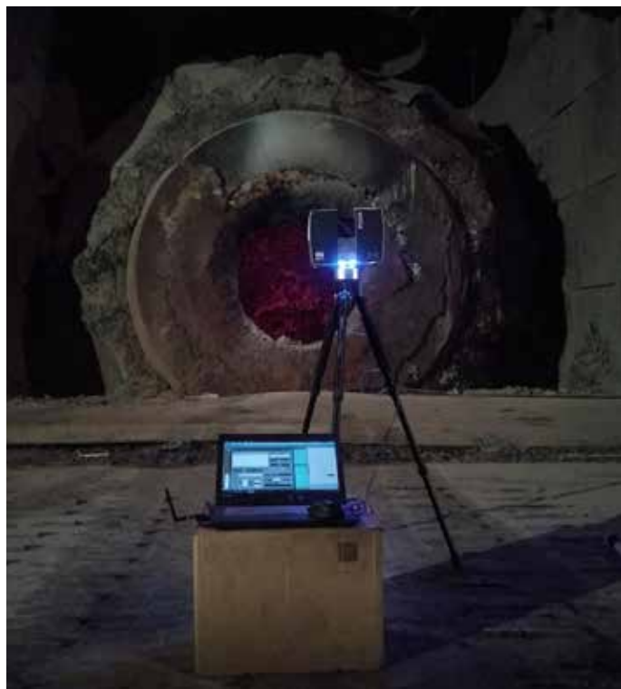
使用 FARO 三维激光扫描仪现场检测。
