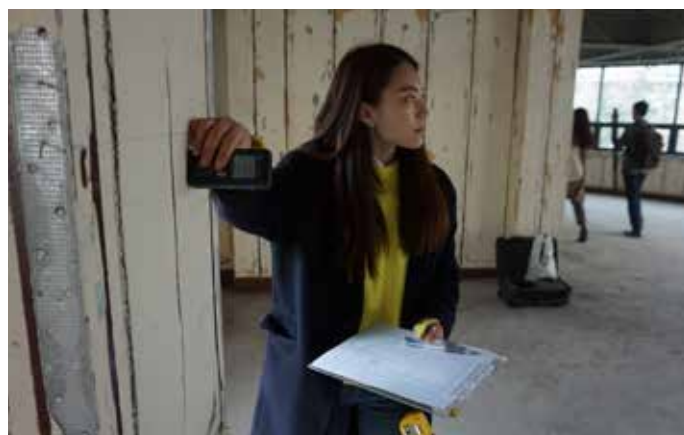
テープとレーザールーラーを使用し、測量を実施するスタッフ。
