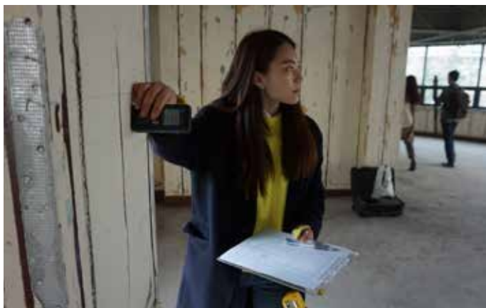
一名员工正在使用卷尺和激光尺进行测量。
