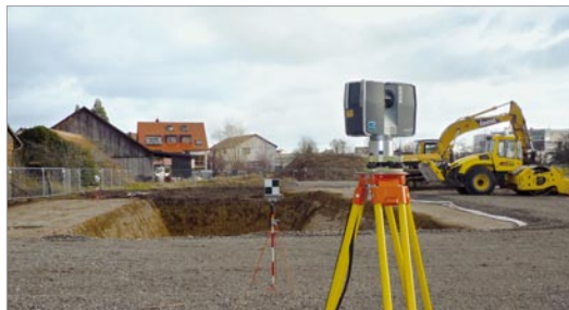
Abb. 7: Volumenberechnung mithilfe eines Laserscanners
