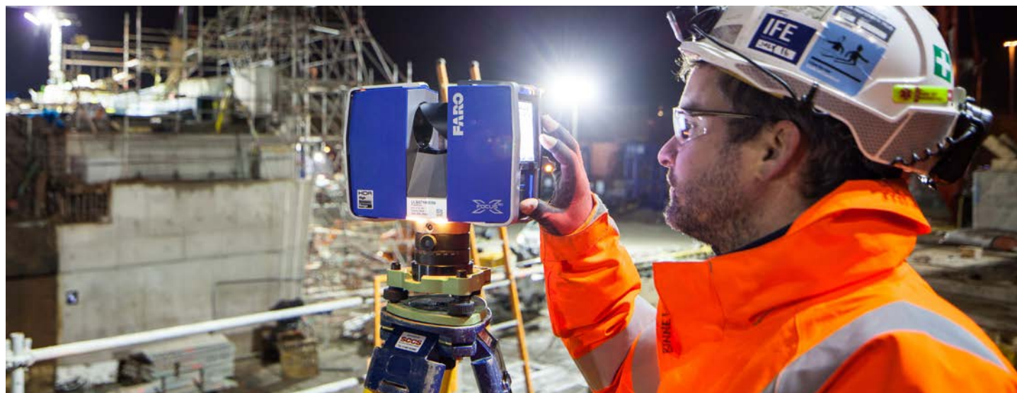
Le FARO® Laser Scanner Focus 3D X330 est utilisé lors du travail préparatoire conséquent qui comprend le réaligement des voies existantes, la construction de nouveaux ponts et le retrait de voûtes non utilisées
