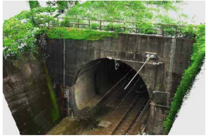
详细记录隧道井口和周围的扶手、电线。
