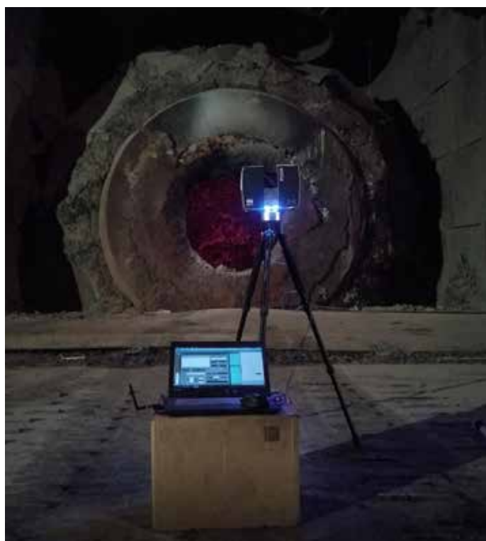
FARO 3Dスキャナーを使い、現場検査。
