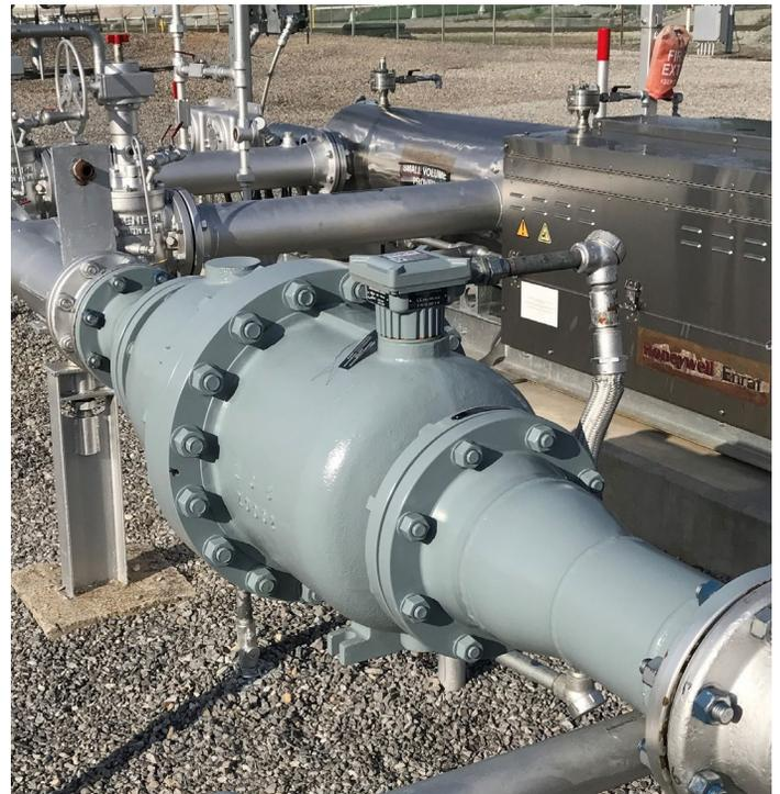
Instalación en el campo de un medidor Birotor Plus Brodie de 8 pulgadas
