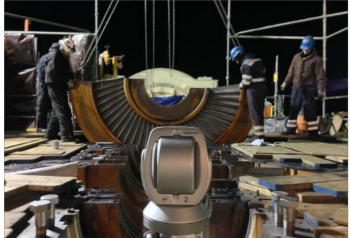
A lógica do uso de equipamentos de laser de última geração e do software adequado é clara e comprovada: o alinhamento rápido e preciso facilita a execução dos serviços e aumenta a eficiência da turbina, o que prolonga a vida útil da unidade e aumenta a margem de lucro do proprietário.
