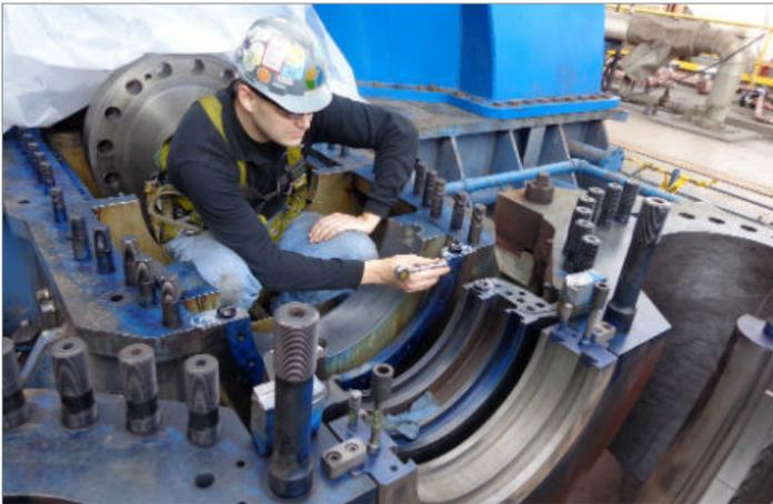
"O alinhamento rápido é uma alternativa ao alinhamento com remoção da parte superior. Com a remoção, a posição do diafragma, os atritos da gaxeta, a ovalização e os desvios da carcaça da turbina são medidos e registrados. Essas medições são usadas para calcular a posição teórica, sem necessidade de remoção da parte superior da turbina", explica Damian Josefsberg, fundador da ACQUIP.
